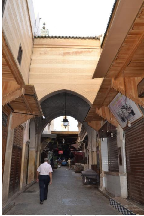
لوحة (٧) توضح المدخل النافذ الذي يمر أعلى الطريق ليربط المدرسة البوعنانية بدار الوضوء التابعة لها (تصوير الباحثة)
